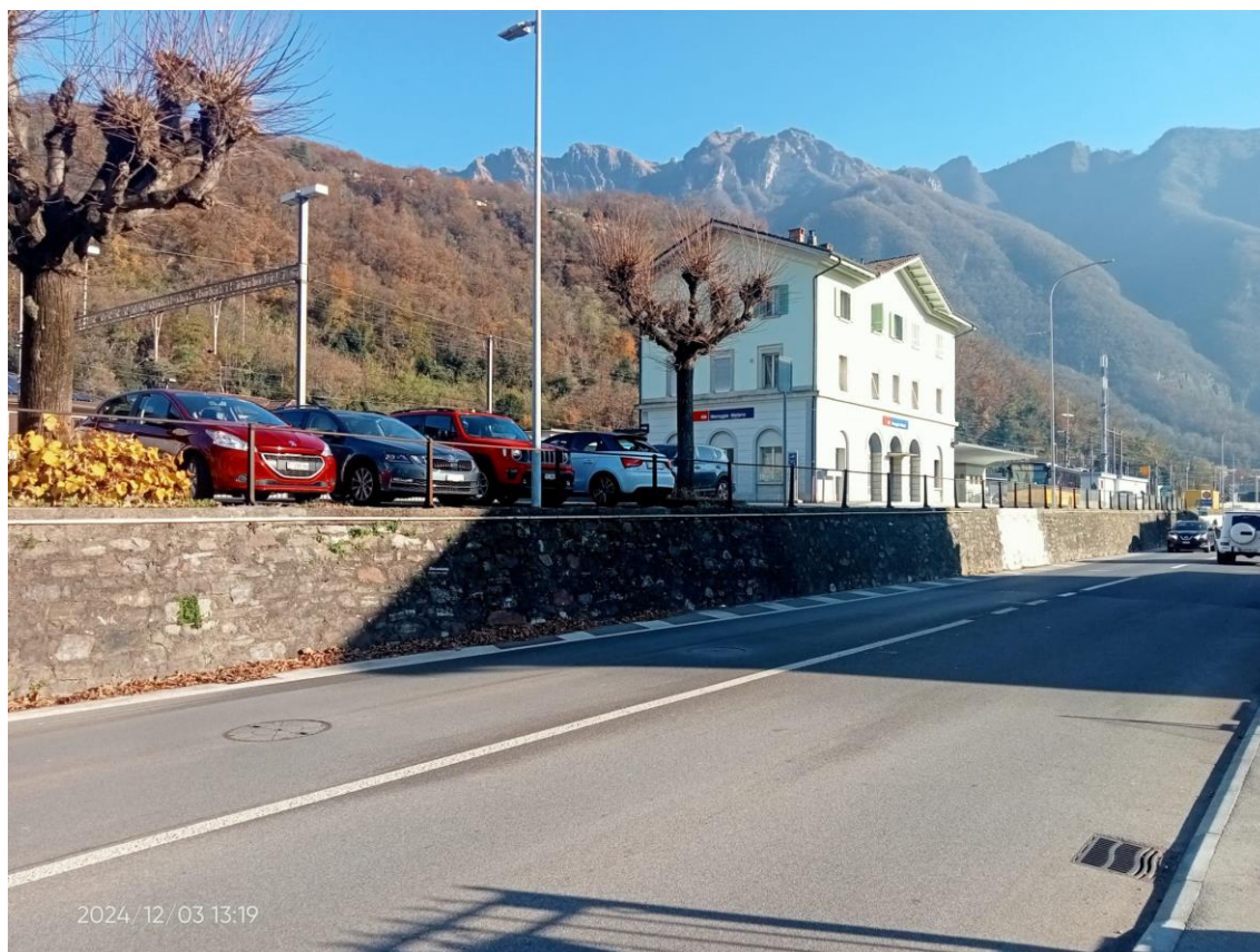
Figura 7 Vista zona parcheggi
